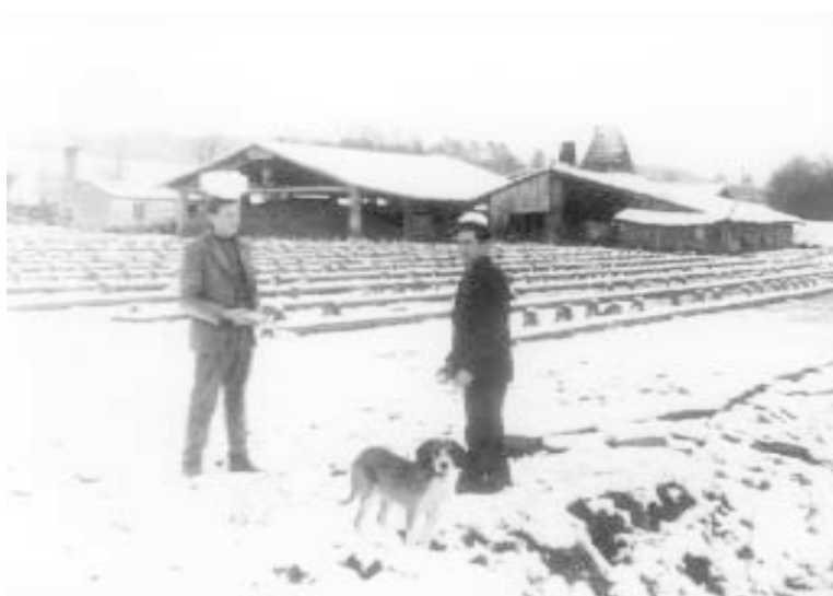
Día de neve na telleira de Lomba. Dous operarios xogan con ela poñéndoa de sombreiro. Ao fondo vense as ringleiras para secar as tellas, as instalacións cos cobertizos e o fomo que sobresa.
